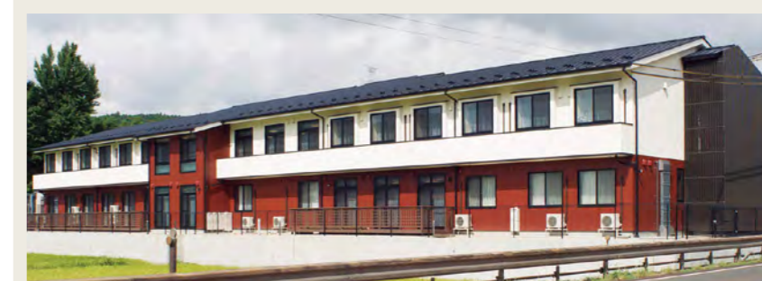
特別養護老人ホームまんでん塩津(木造2階建ツーバイフォー工法 平成24年6月竣工)
